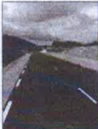
Des travaux amorceés fin 2013.
